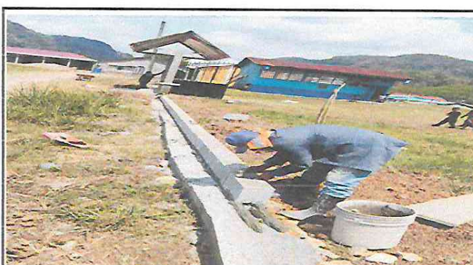
Foto 4: Se Observa el avance del del muro perimetral.
