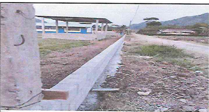
Foto 5: Se Observa el avance del del muro perimetral.
