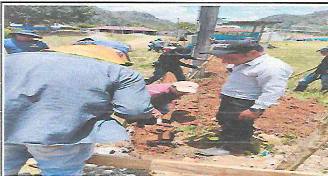
Foto1: Se observa el inicio de la excavación del muro perimetral.
